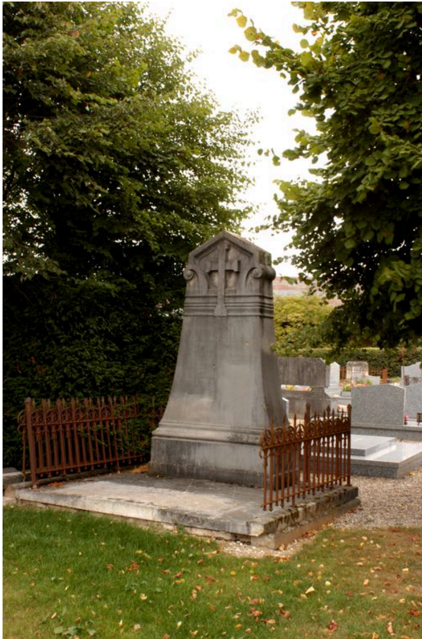
Stèle funéraire de la marquise de Saveuse, 1er quart 20e siècle. Adolphe Carette (entrepreneur). La concession dispose à l'origine d'un accès particulier. Saveuse.
