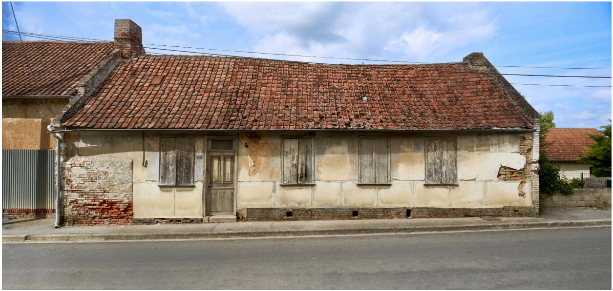
Vue sud de la deuxième maison, depuis la rue.
