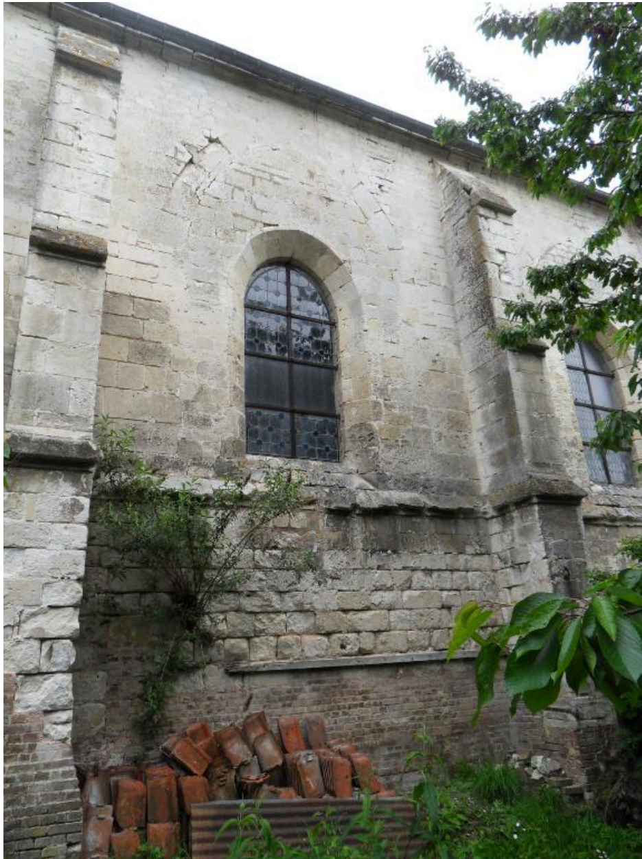
Baie du mur sud (deuxième travée).
