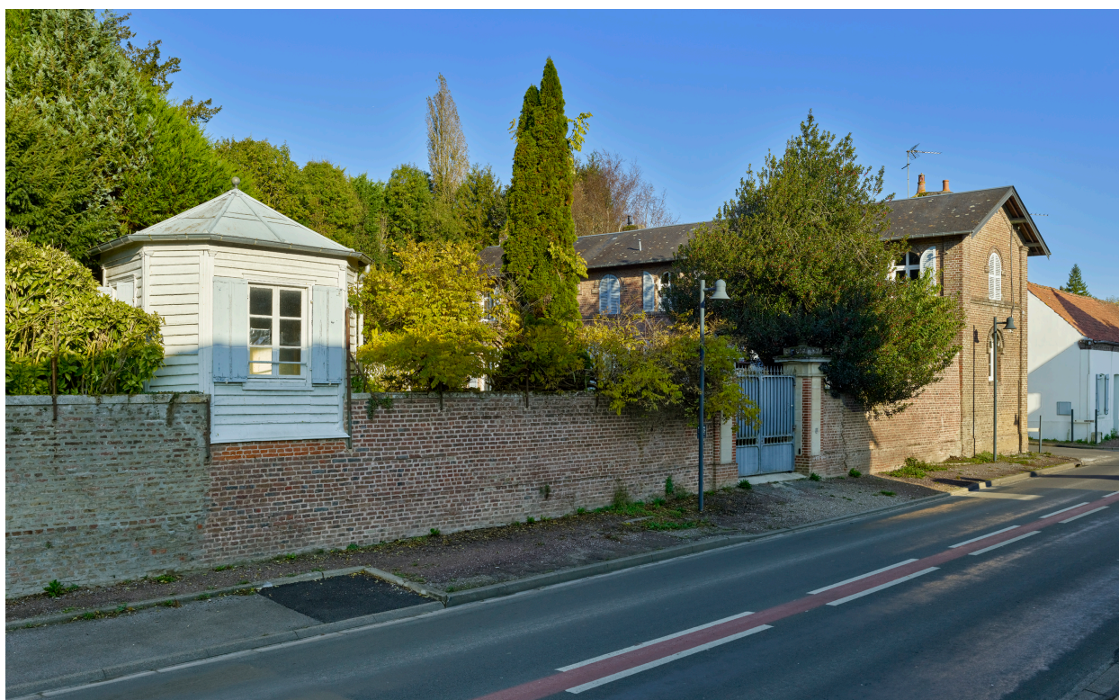
Exemple de grande demeure à étage route de Paris.
