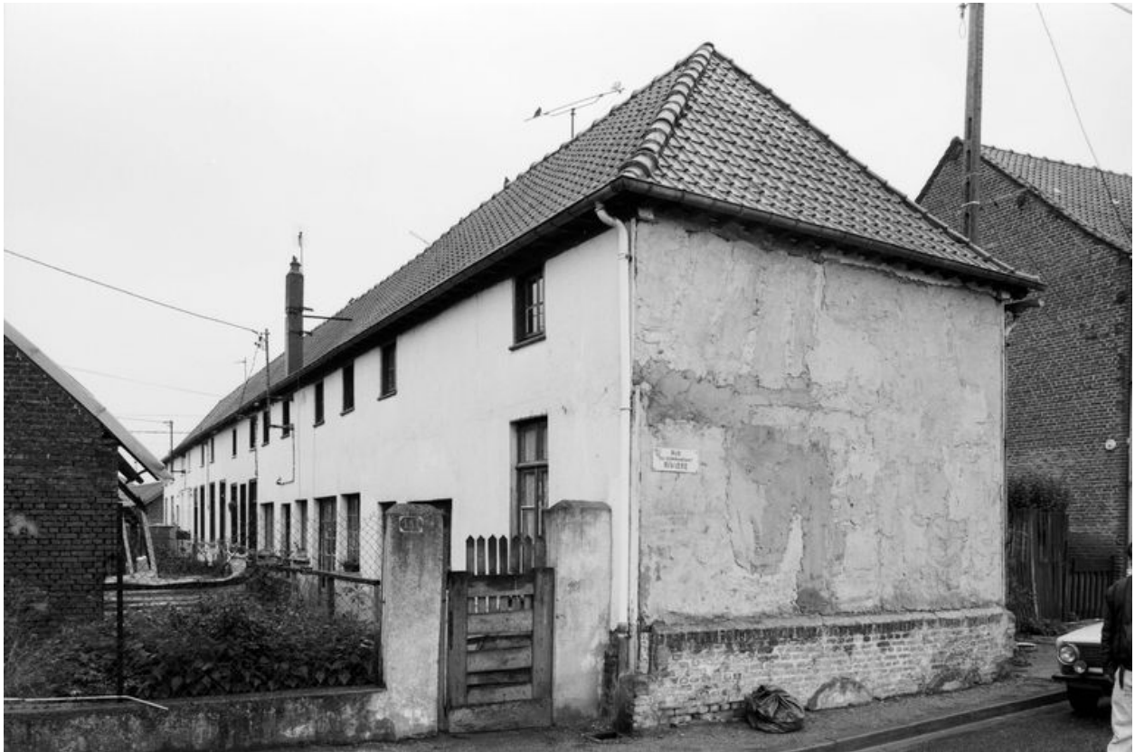
Vue des habitations à bon marché (106 à 118 rue Georges-Outrebon), imposées comme constructions neuves en 1898.
