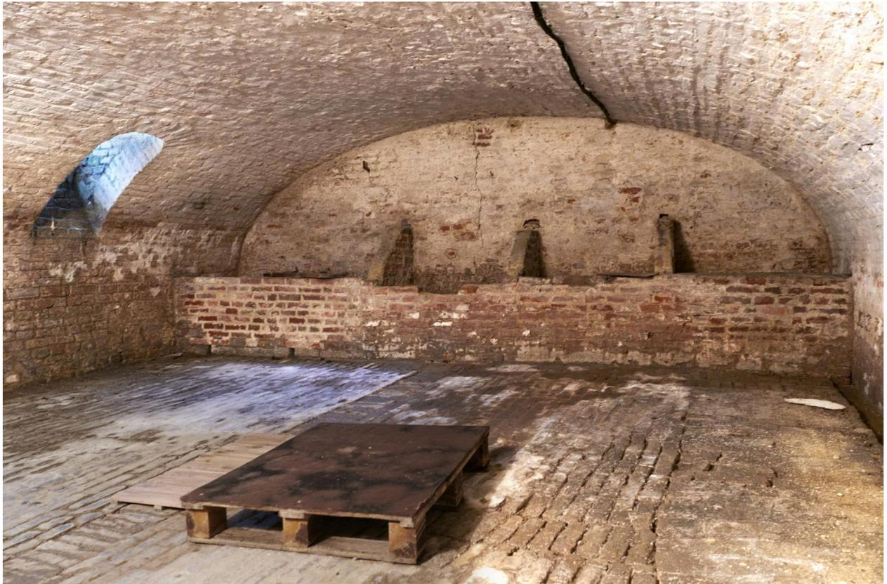
Cave de 1780 voutée en arc surbaissé, réalisée en brique avec badigeon de chaux.
