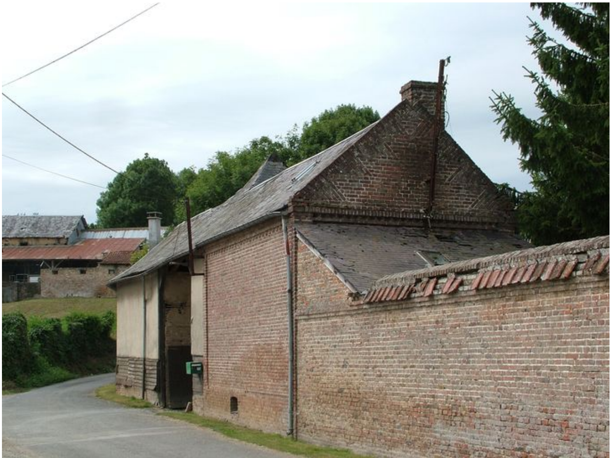
Mur de clôture et bâtiments sur rue.
