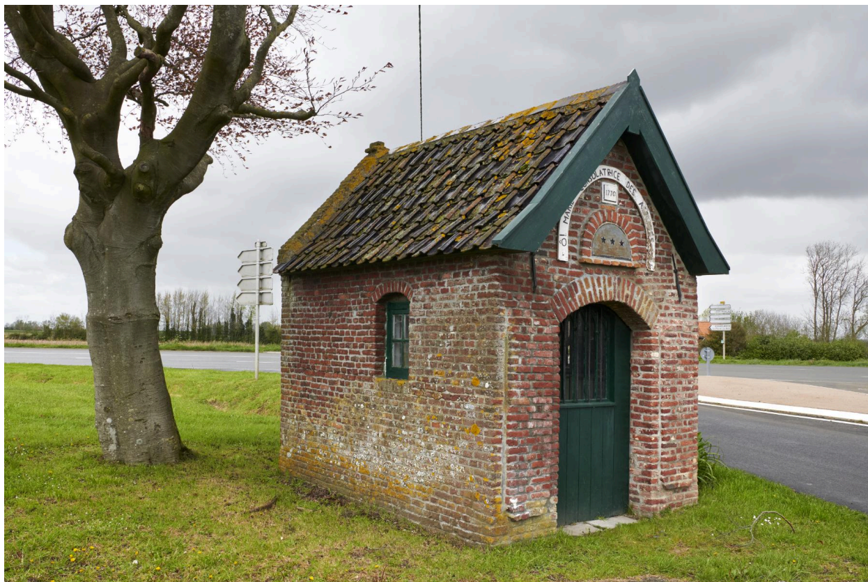
Vue générale depuis le sud-ouest.
