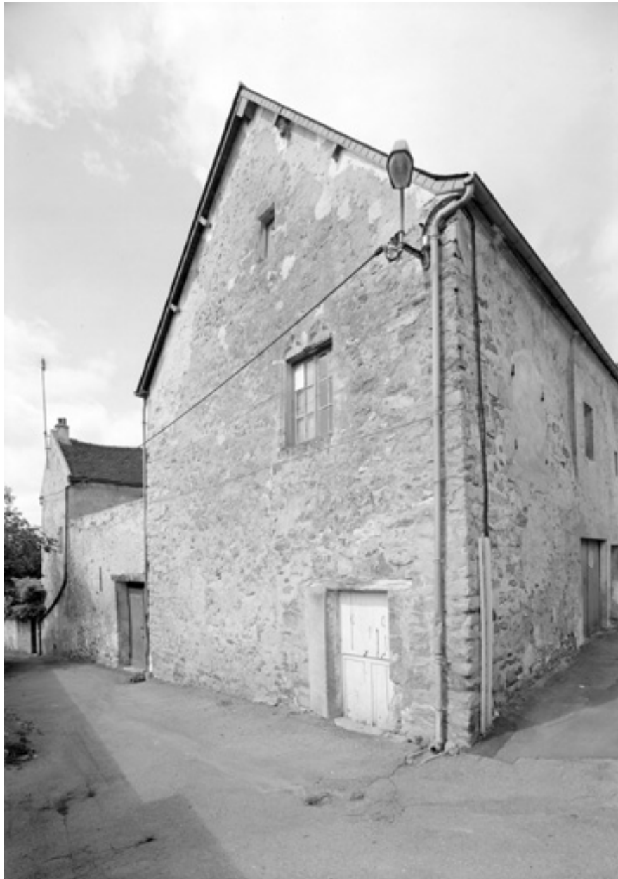
Vue de la façade sur la ruelle du moulin à Tan.
