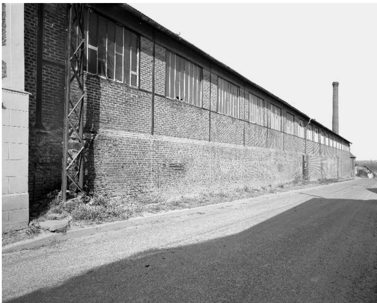
Atelier de fabrication, élévation antérieure.
