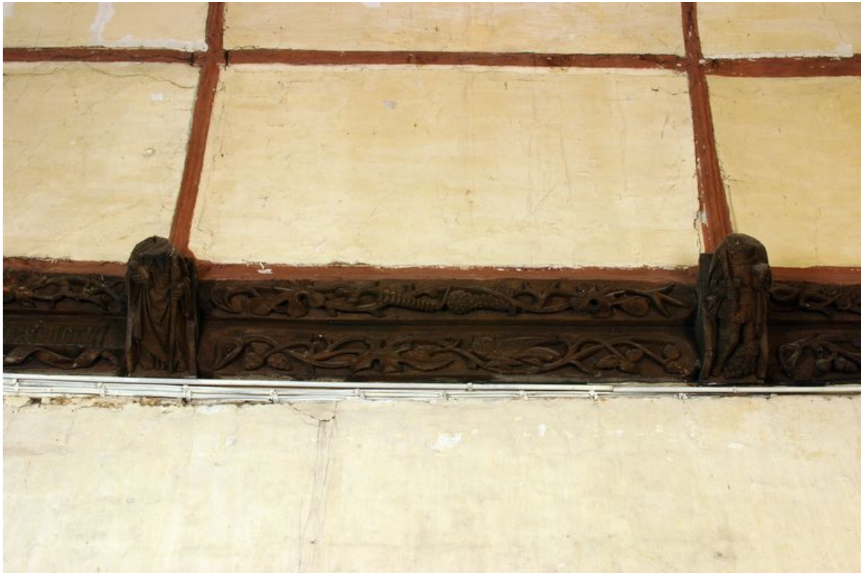
Vue détaillée de la sablière haute du chœur avec décor végétal et blochets bûchés.
