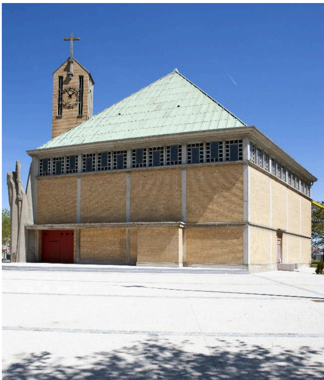
Élévation sud et est de l'église.
