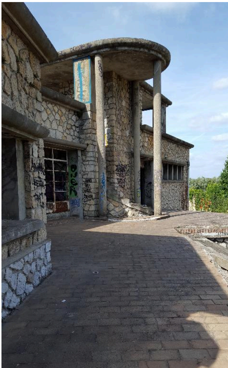
Détail du porche d'entrée de la piscine.
