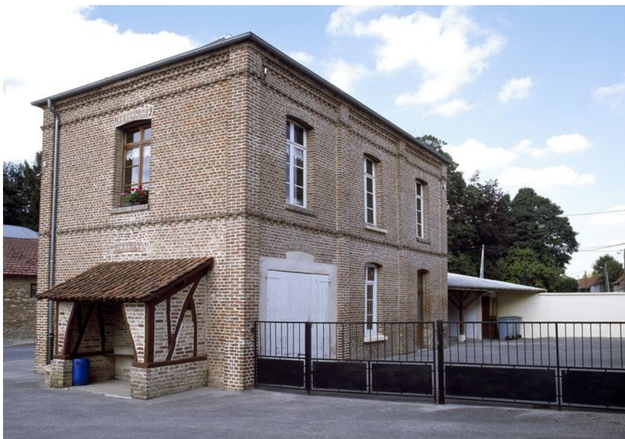
Vue arrière du bâtiment et de la cour.
