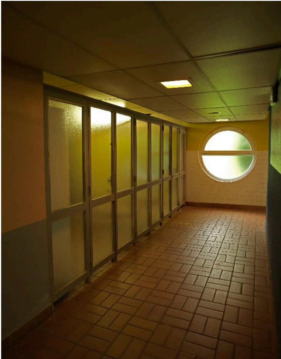
Portes d'entrée de l'un des deux vestiaires collectifs.
