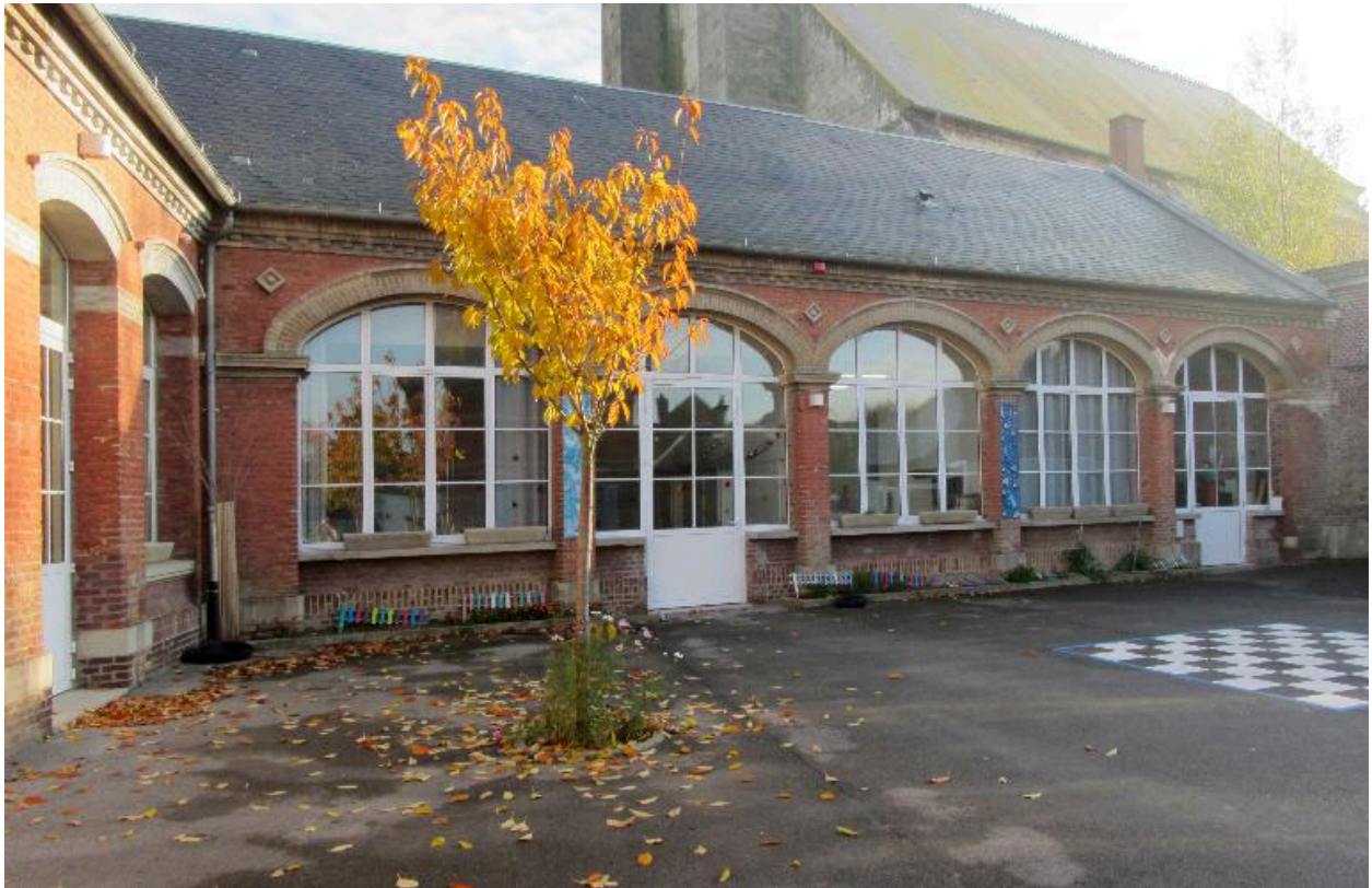
Façade sur cour des salles en retour.
