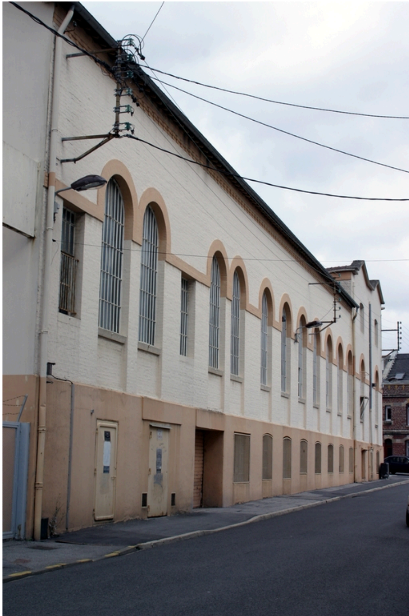
Façade des ateliers restaurés en 1919, rue Bénézet.
