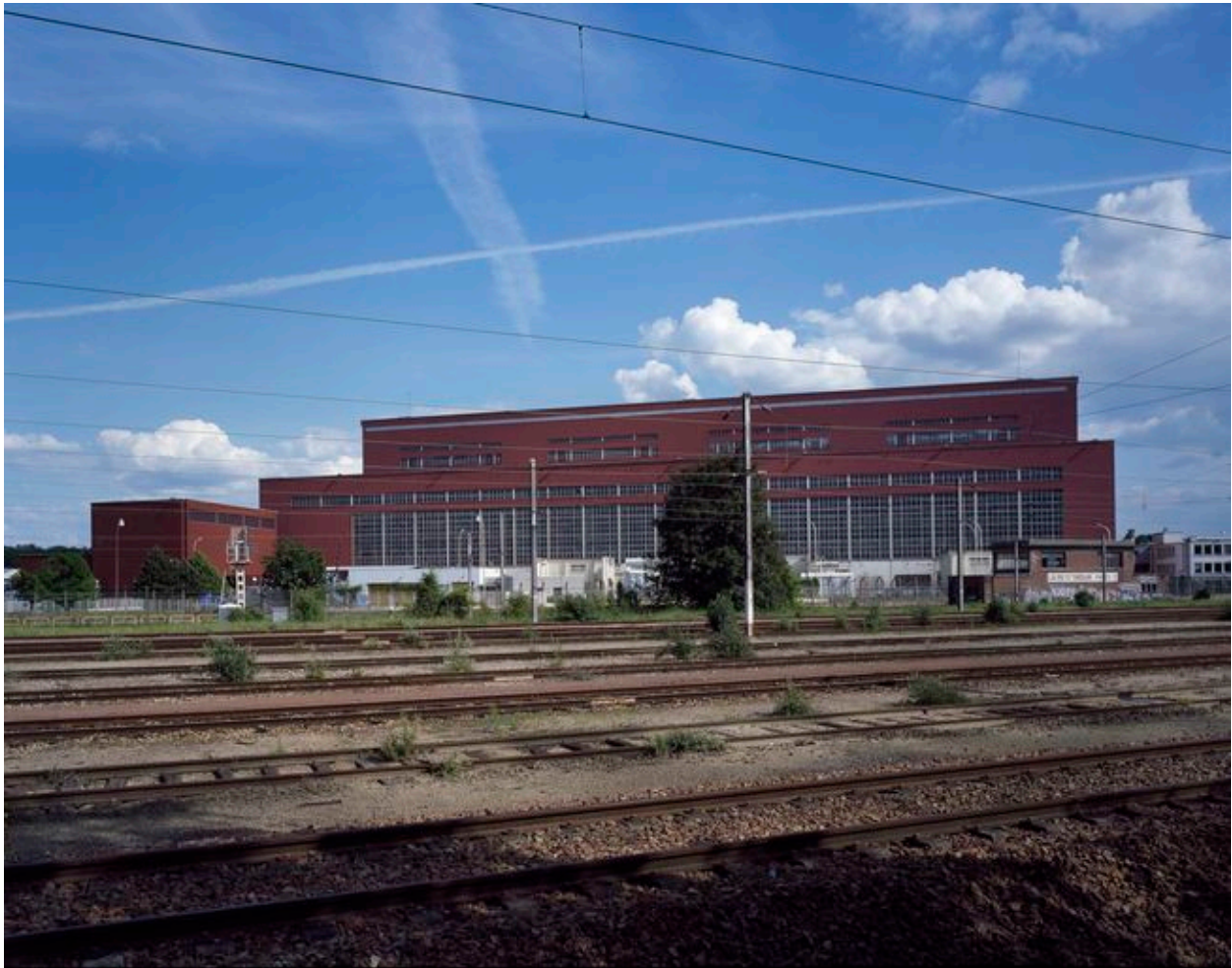
L'ancienne centrale depuis les voies ferrées.
