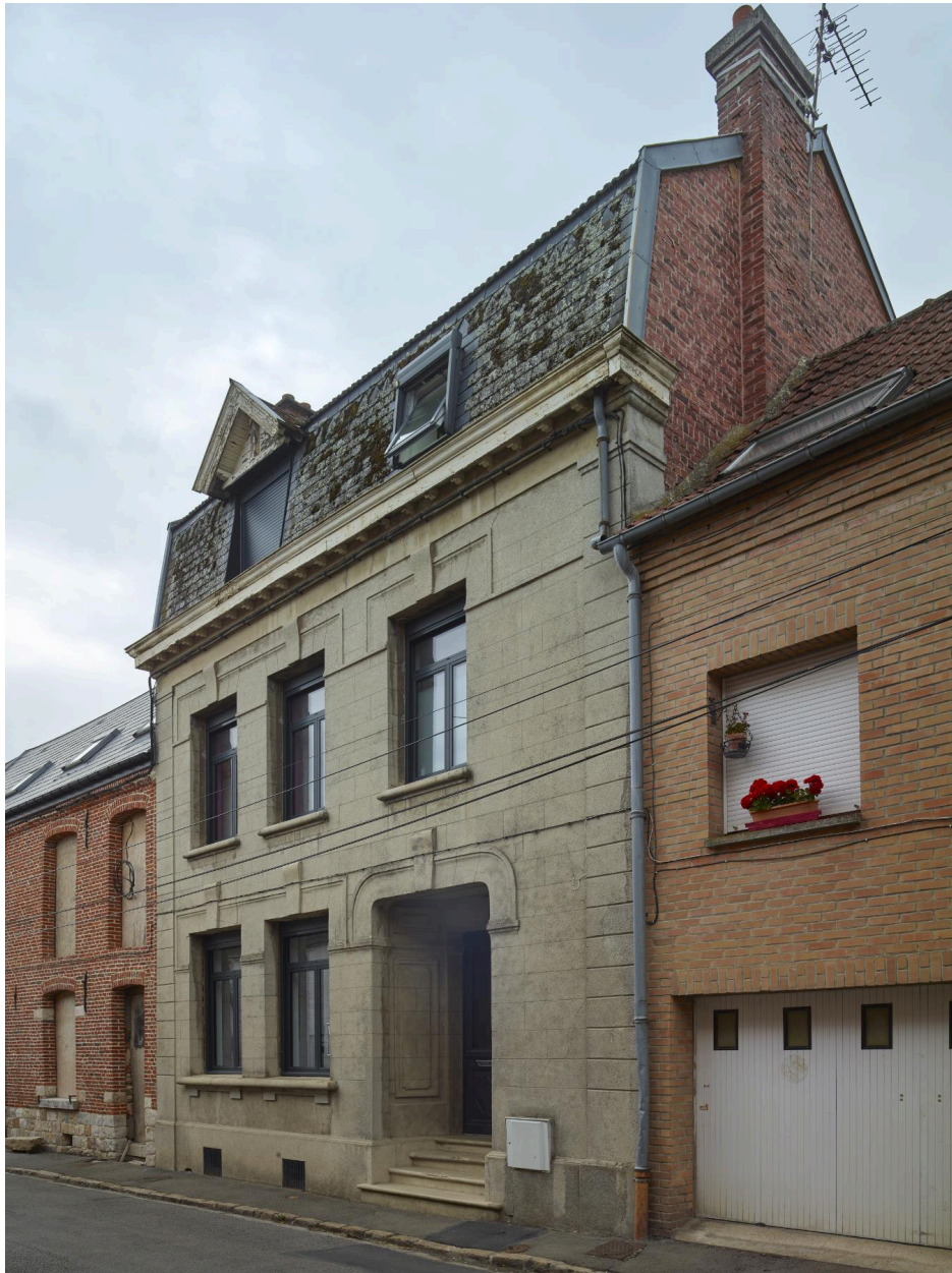
Façade principale. Vue orientée ouest/est.
