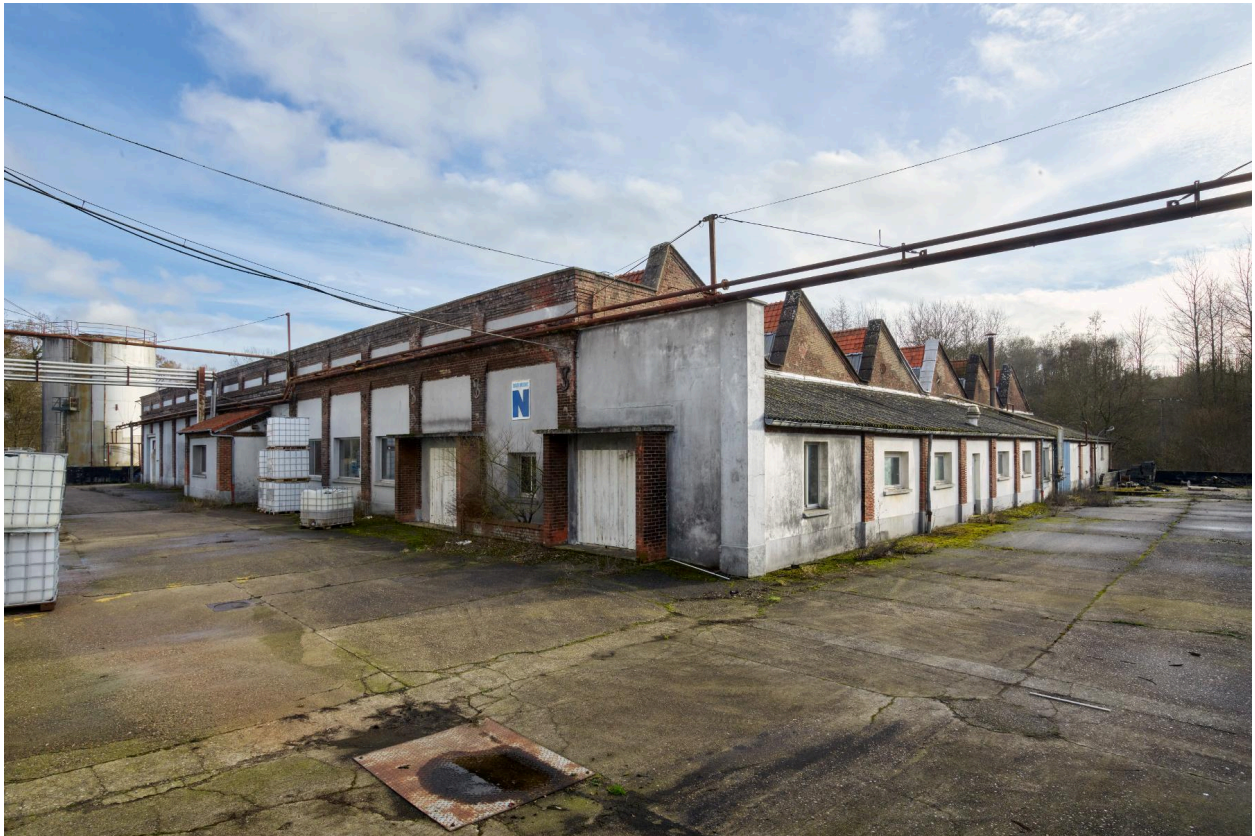
Ancien atelier transformé en laboratoire, vue générale nord-ouest (bâtiment N).
