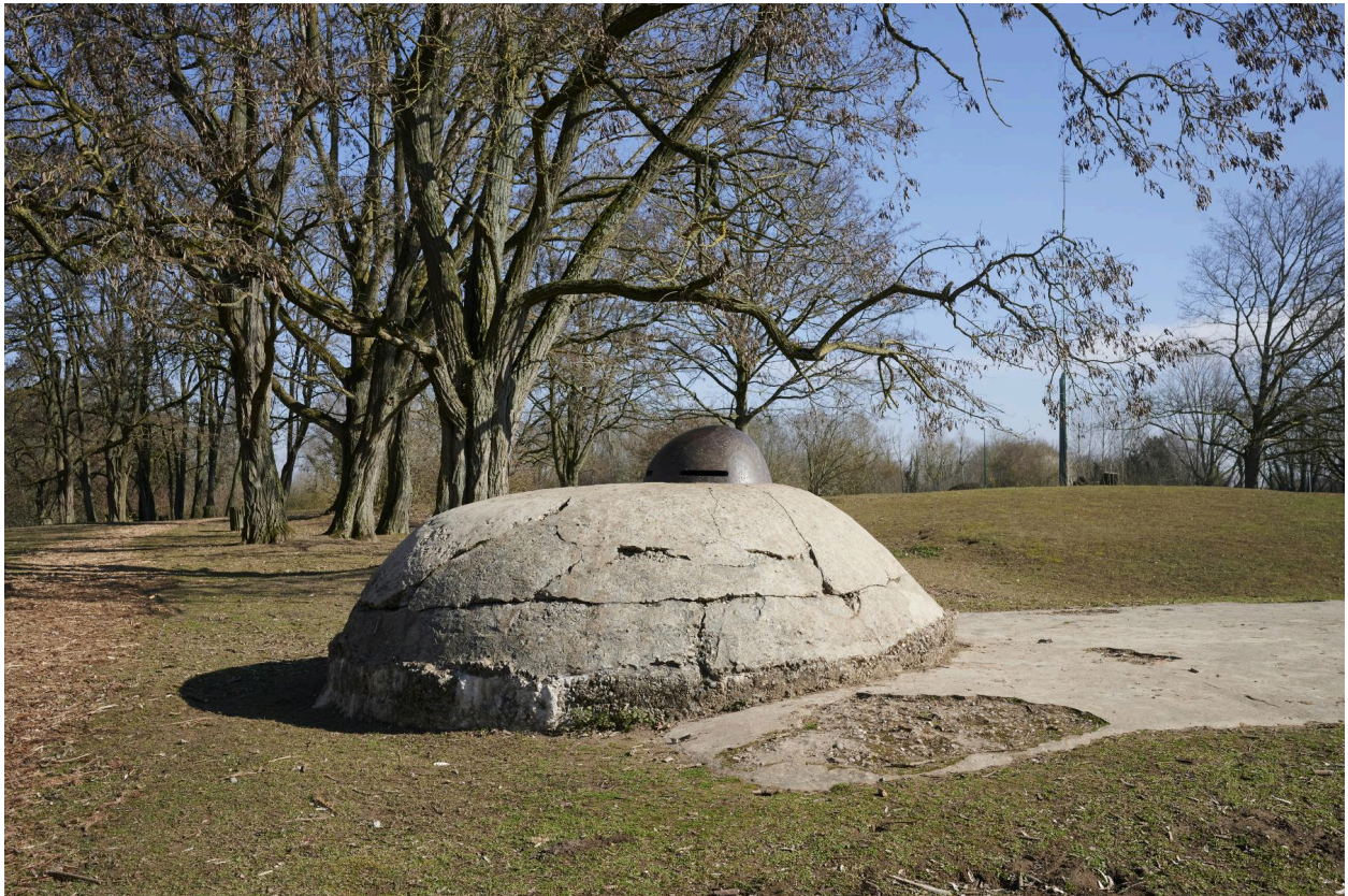
Abri casematé avec observatoire cuirassé. Détail de la coupole vers le sud-est.
