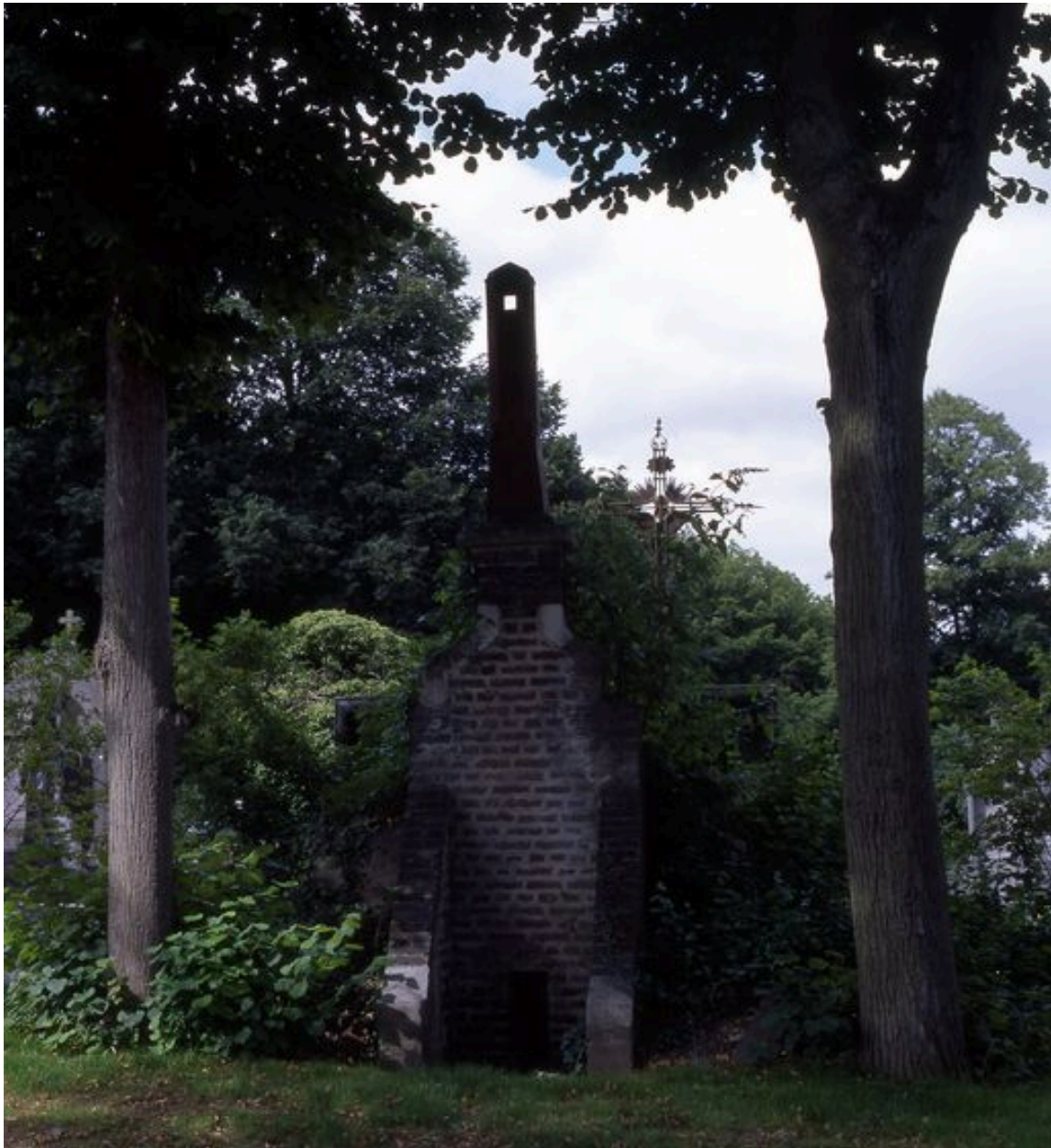
Le dépositoire, vue depuis le nord.
