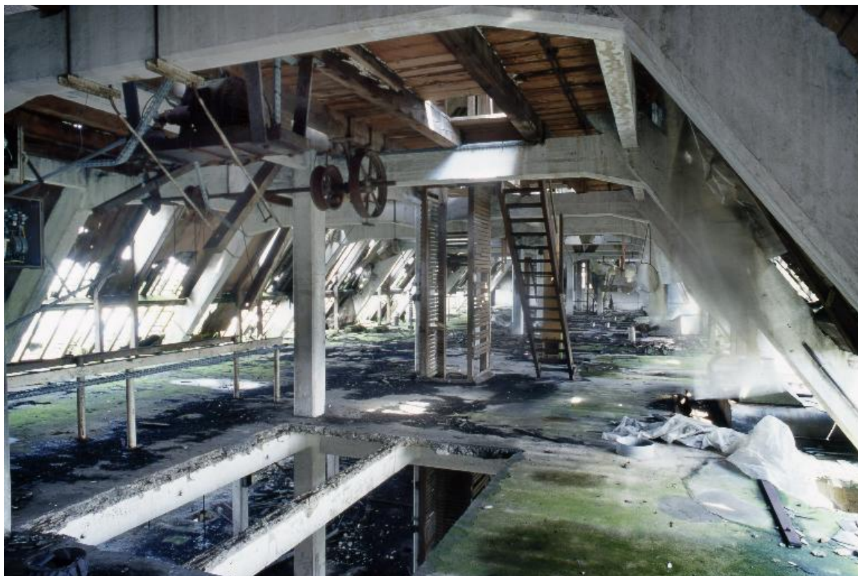
Bâtiment des moulins. Deuxième niveau de comble.
