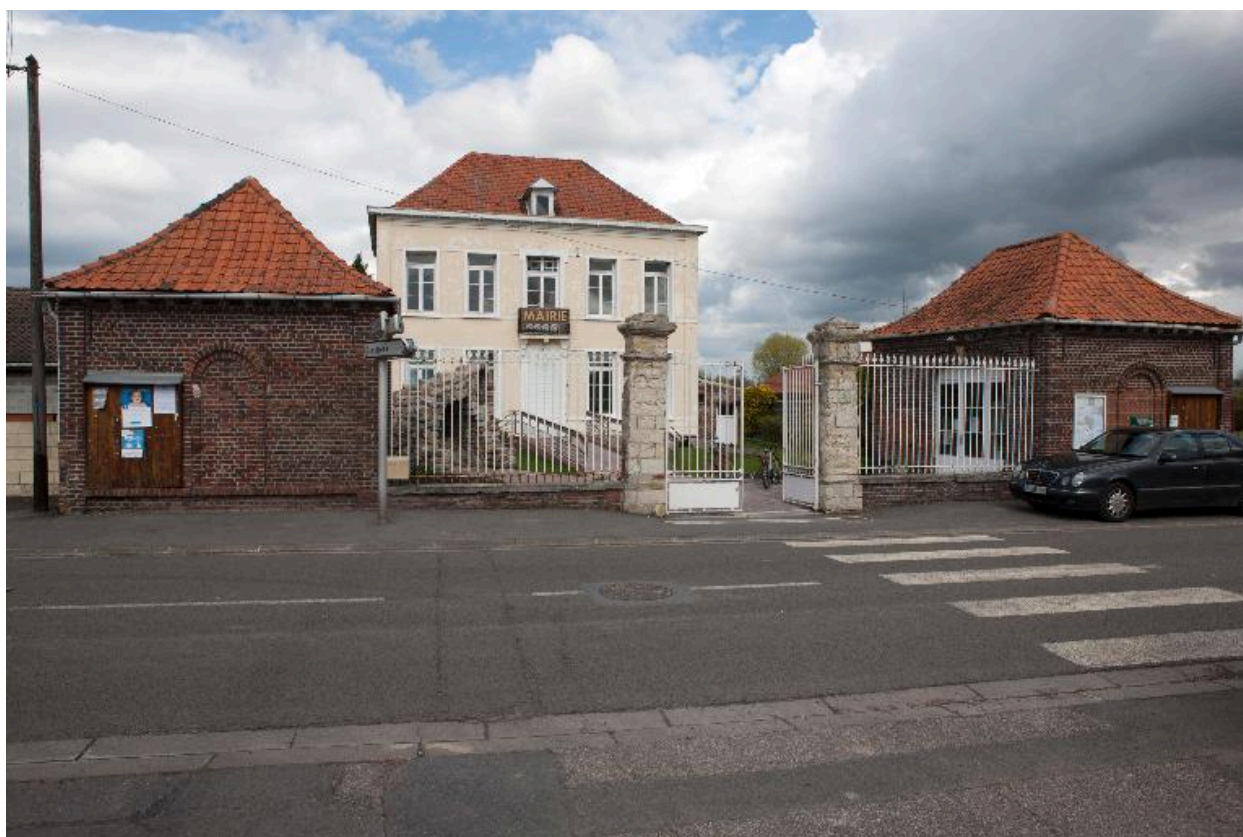
Vue générale de l'ancienne maison et ses dépendances.
