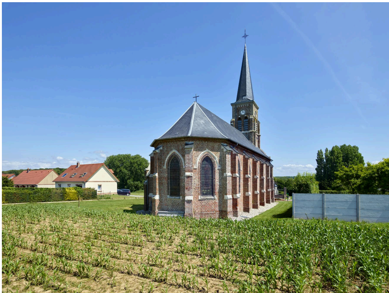
Vue d'ensemble sud-ouest de l'église paroissiale.
