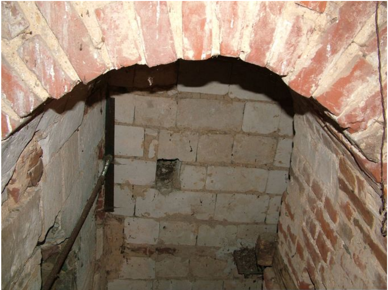
Partie supérieure de la baie sud de l'ancien clocher-mur.
