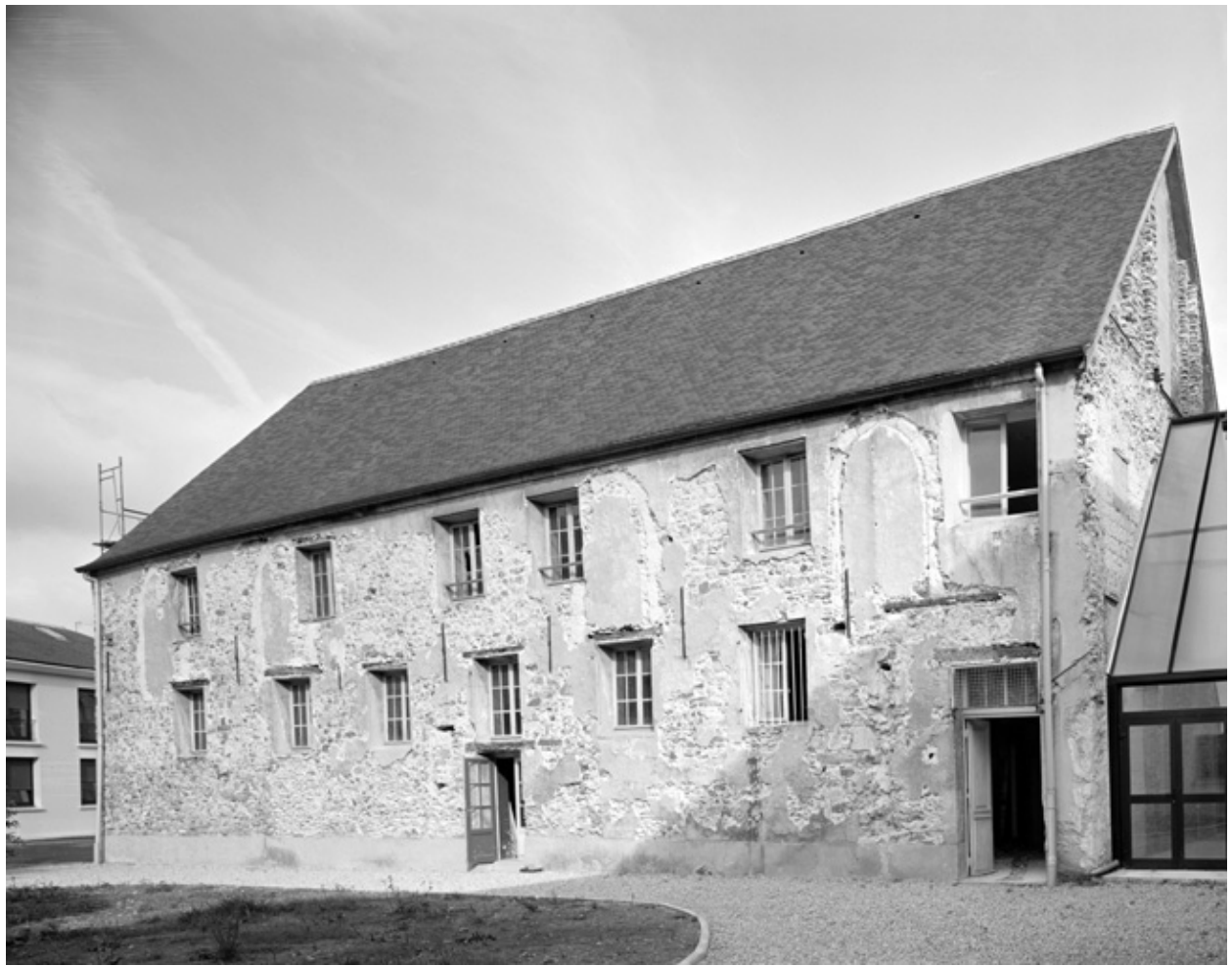
La face occidentale de l'ancienne chapelle, en cours de travaux.
