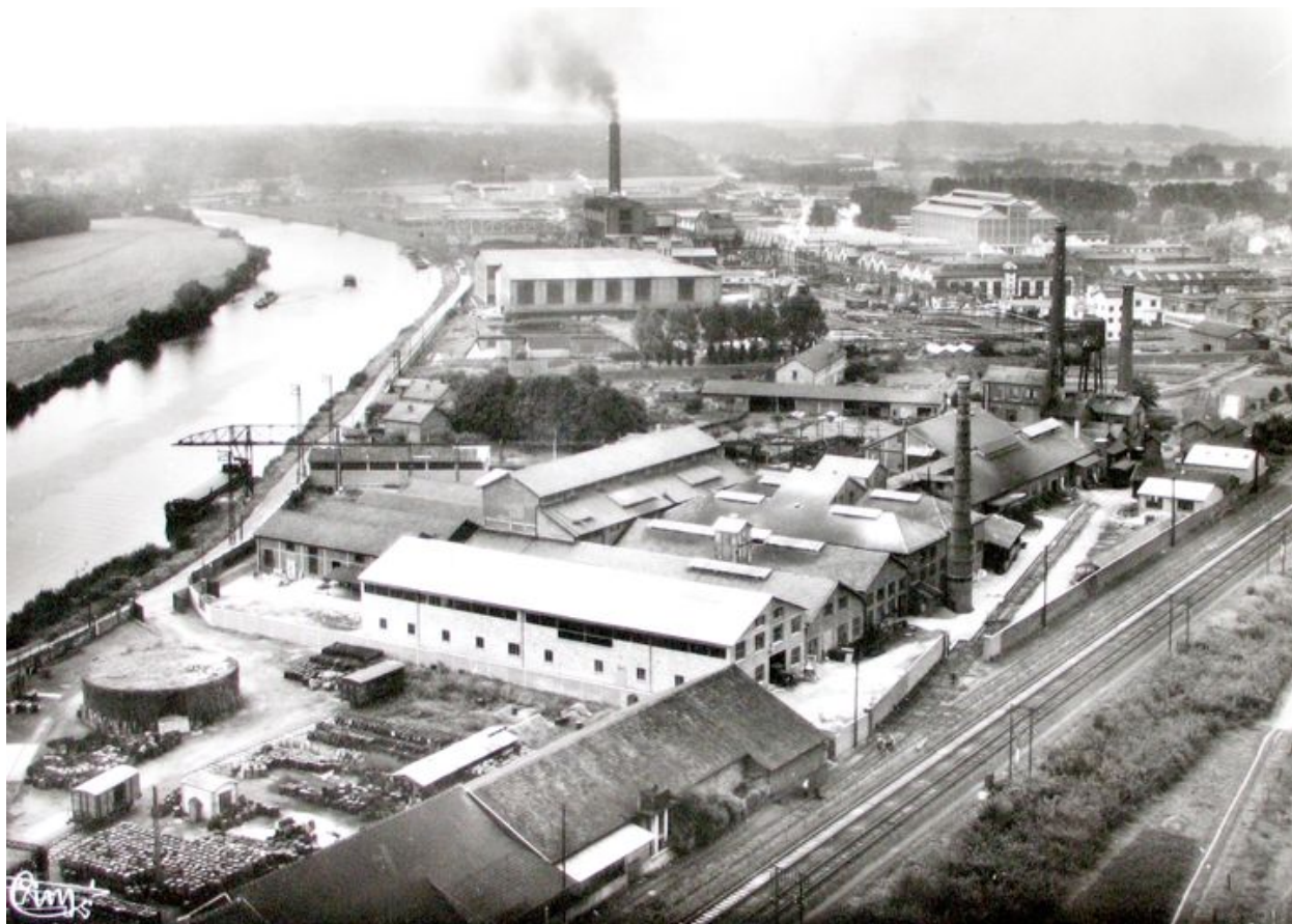
Vue générale de la plate-forme chimique dans les années 1940, au premier plan l'usine de minium de plomb de Rieux (AC Villers-Saint-Paul ; fonds local).
