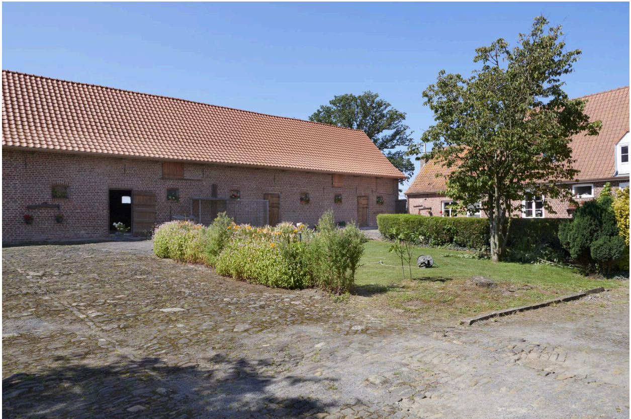
Bâtiment agricole sud, façade sur cour.
