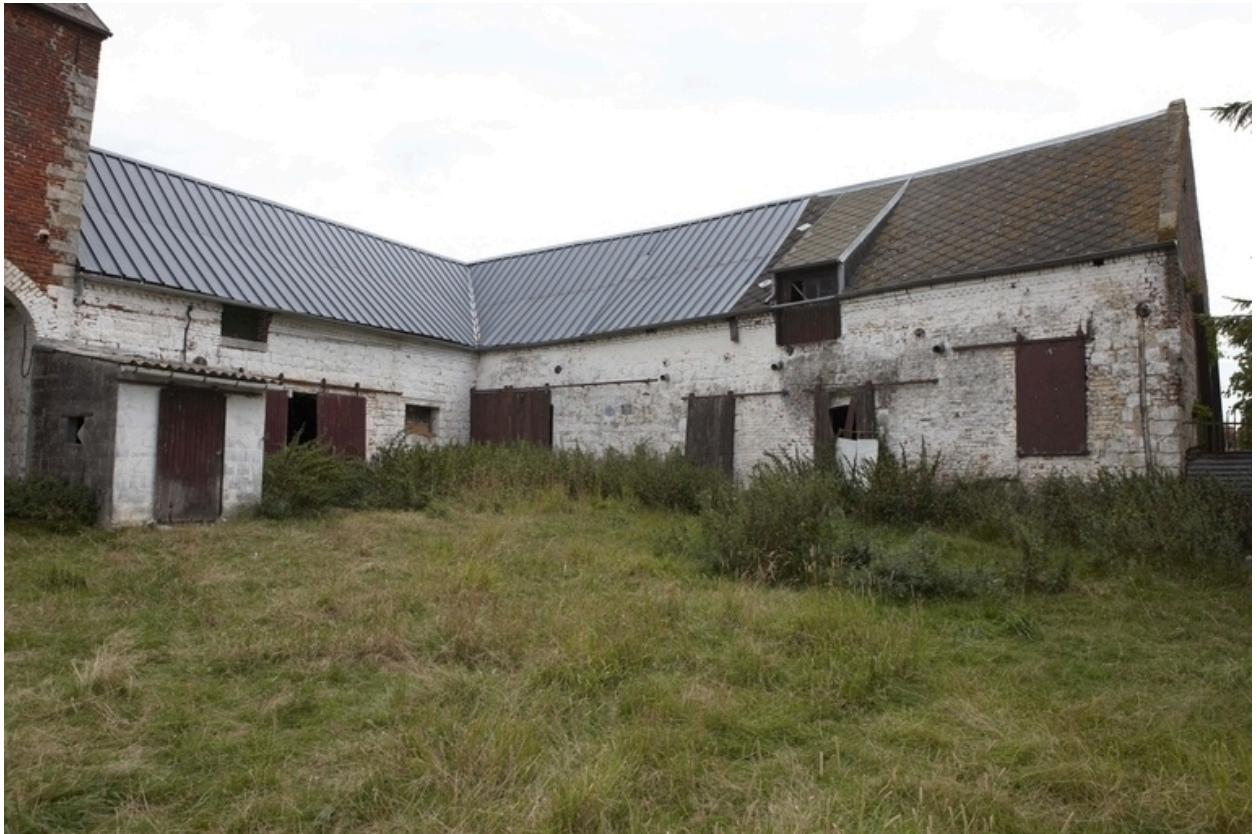
Vue, depuis la cour, du revers des étables situées au sud-est.
