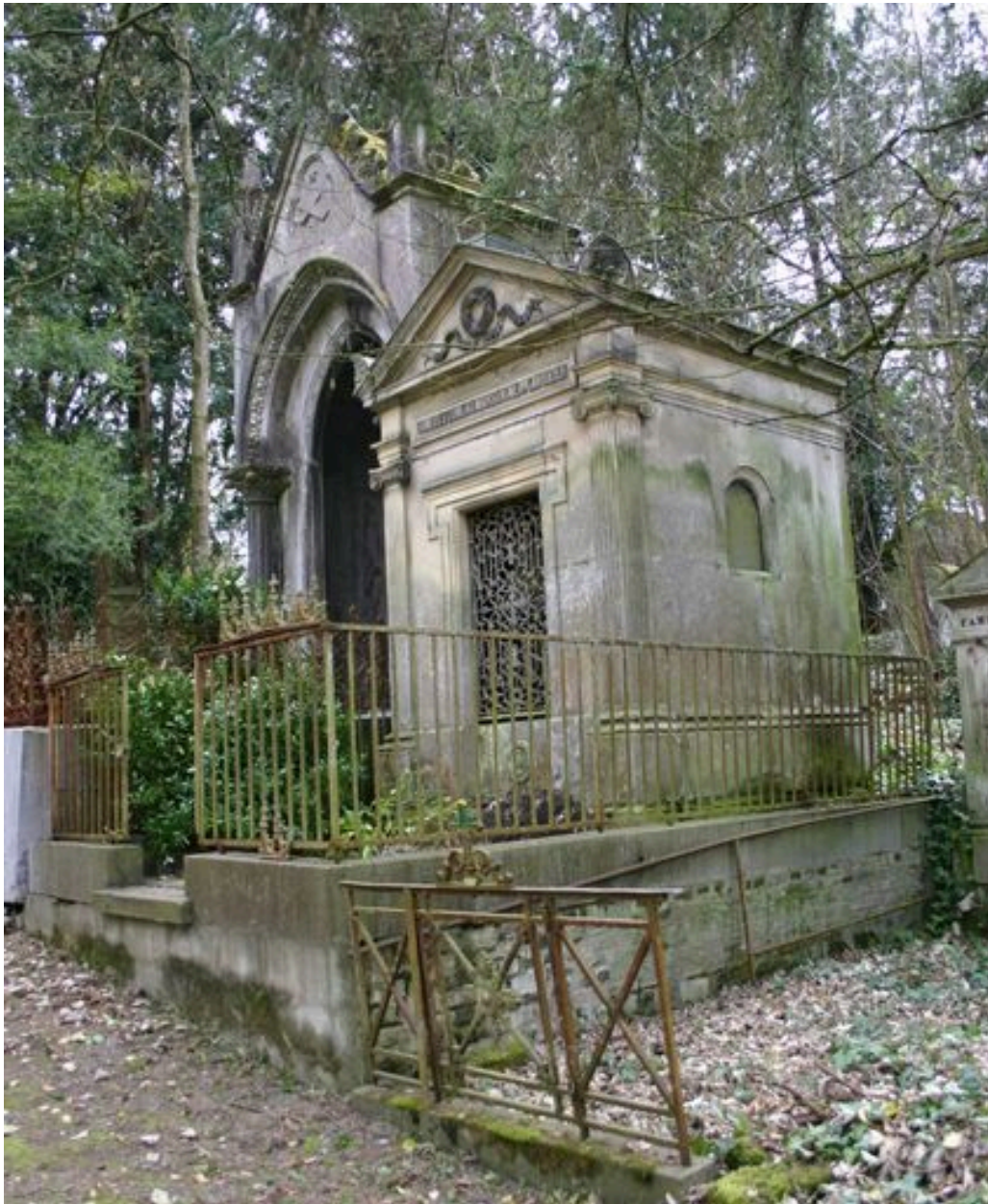
Vue générale, depuis le côté.
