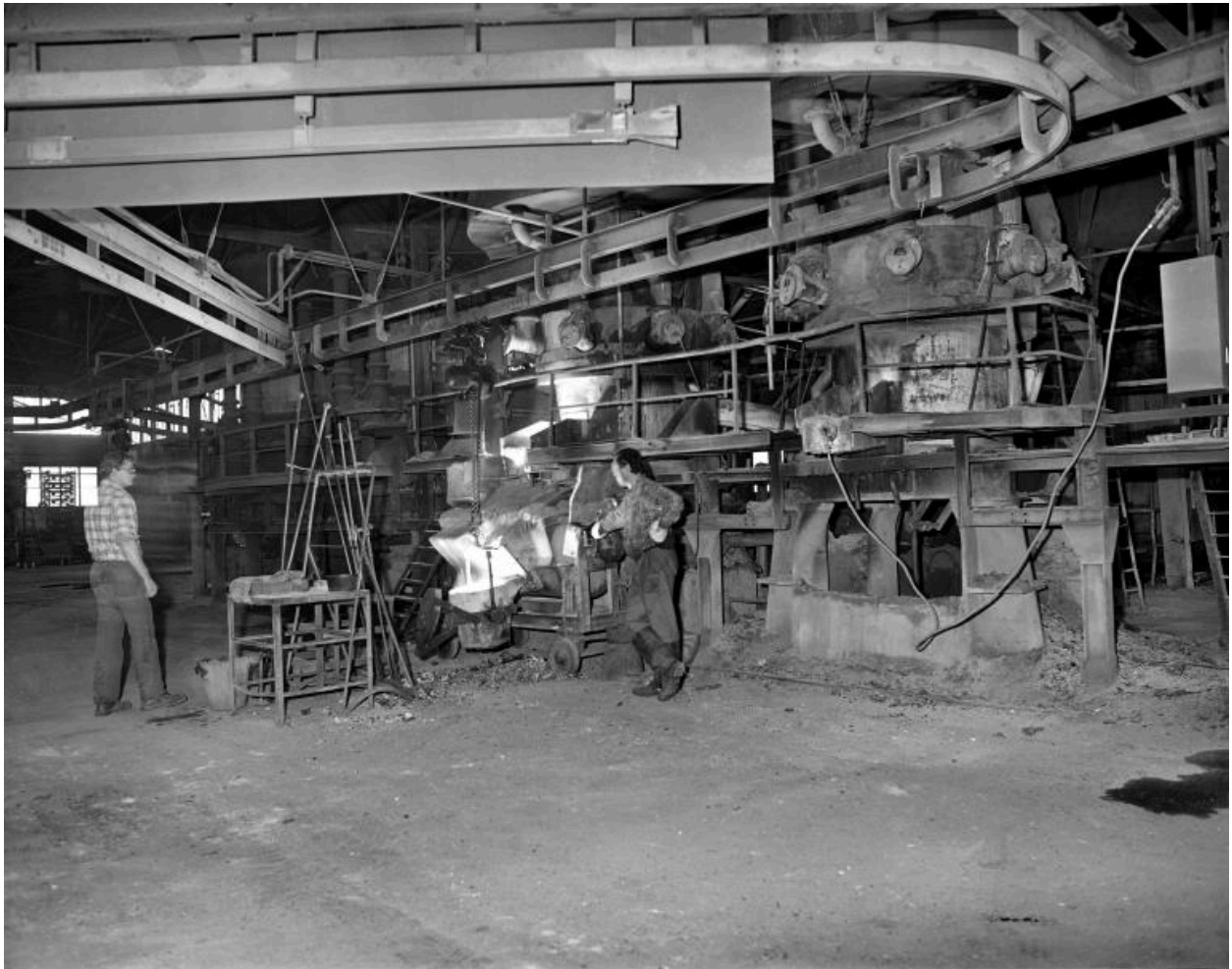
Vue de 2 cubillots de fours, dont un en cours de coulée.
