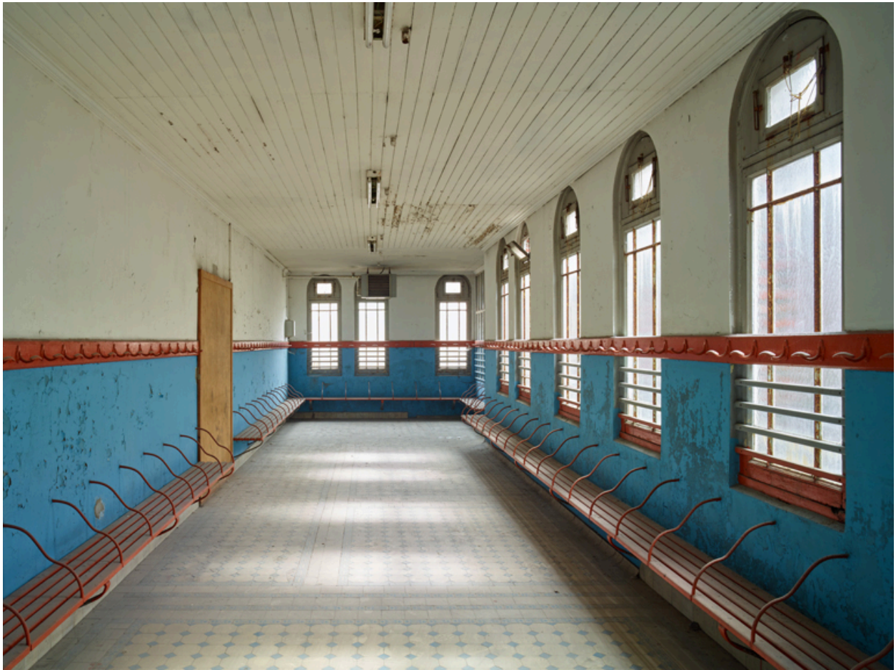
Aile nord, premier étage. Ancienne hydrothérapie des bains de luxe pour hommes, réaménagée en vestiaire collectif. Vue vers le nord.
