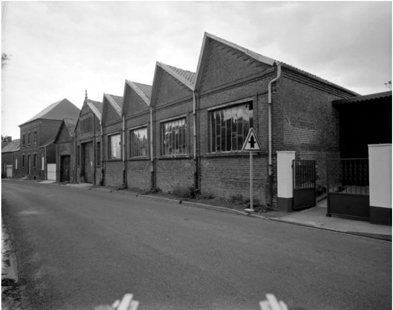
Atelier de fabrication et logement patronal, élévation antérieure.
