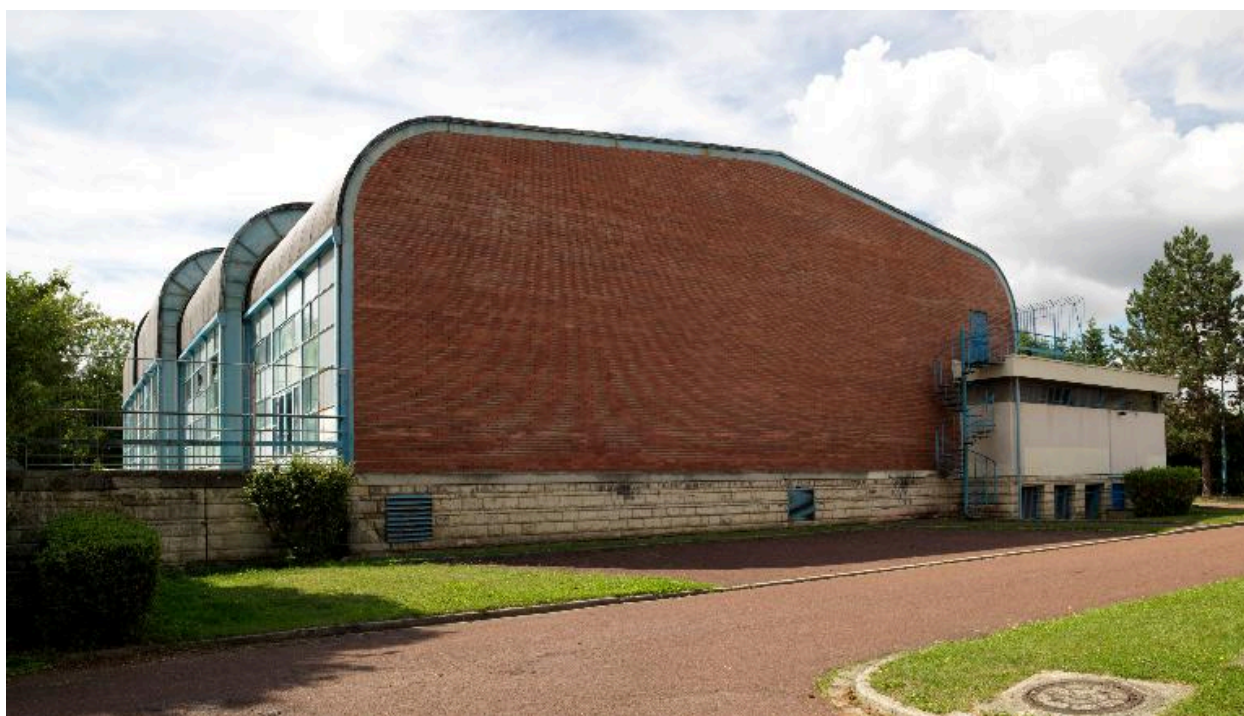
Pignon est (façade arrière de la piscine), avec escalier de secours.
