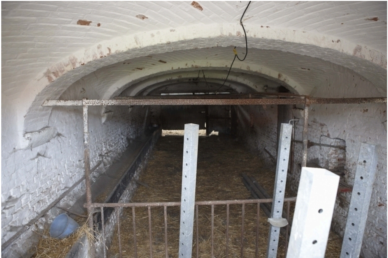
Vue de l'étable située derrière le fronton.
