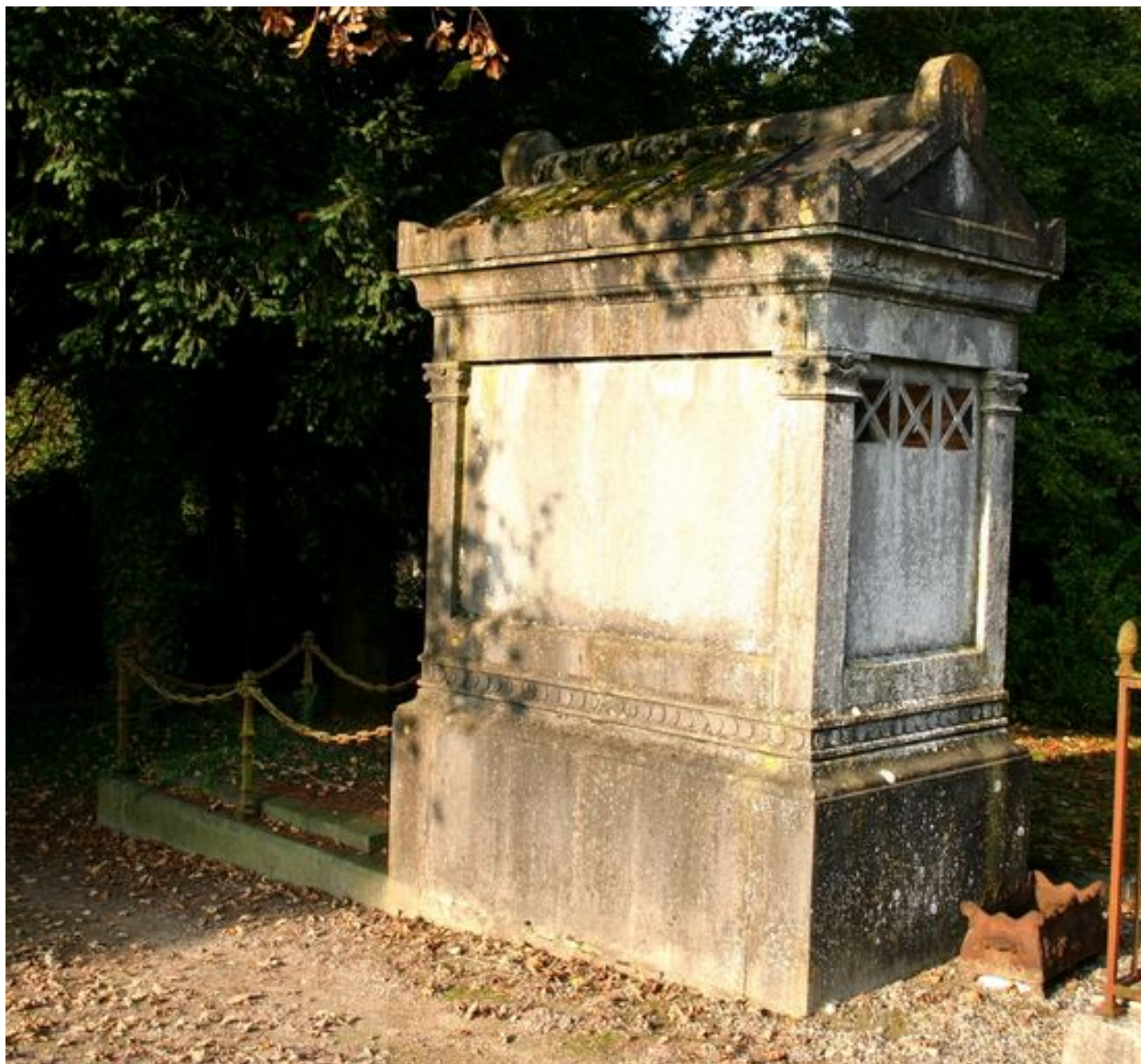
Vue générale postérieure.
