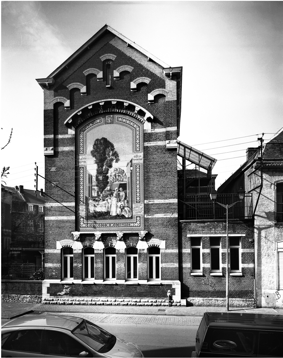
Vue générale du pignon de l'école primaire depuis la rue de la Croix.
