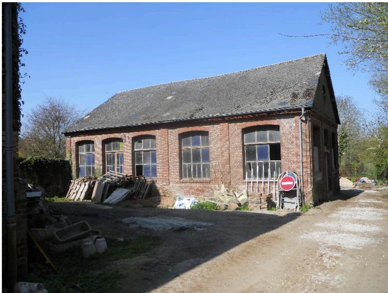
Vue de la fonderie.
