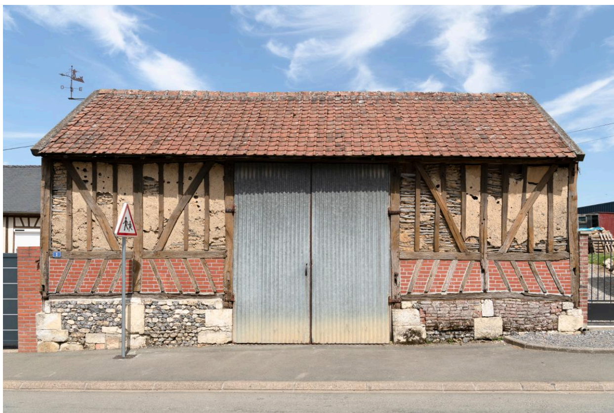
Ancienne grange sur rue, n°1 rue Tassart, vue depuis le sud-ouest.
