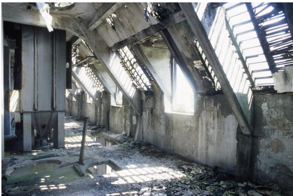
Bâtiment des moulins. Premier niveau de comble
