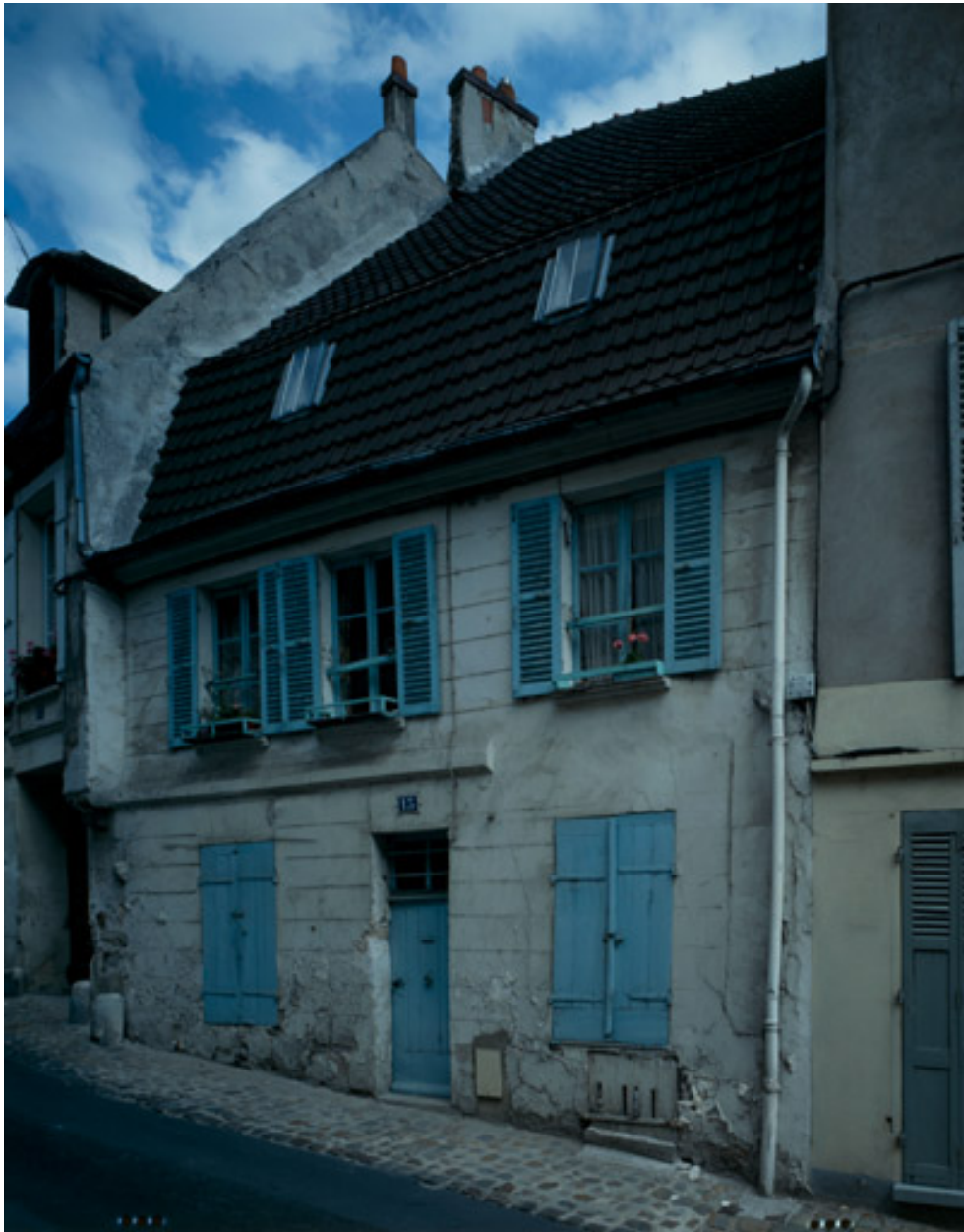
Maison, 15 rue du Château.
