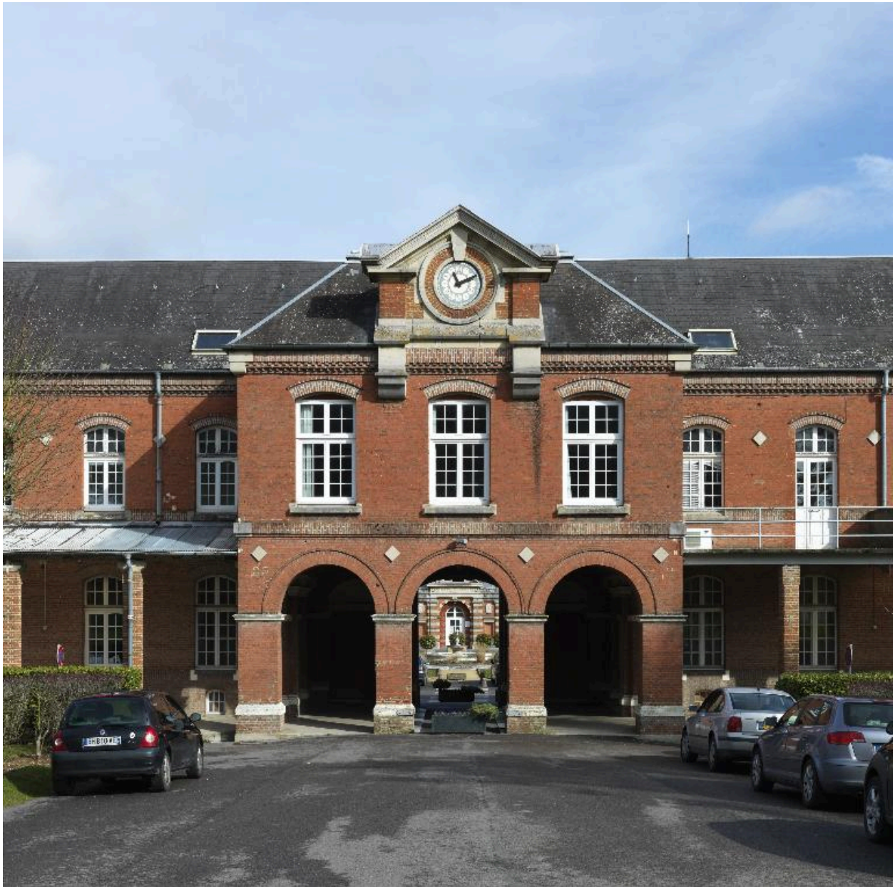
Le pavillon central du bâtiment de l'administration. Façade sud.
