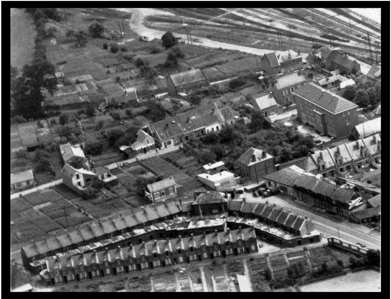
La cité ouvrière. Vue aérienne par Henrard, 1955 (AD Somme ; 3 Fi 127).
