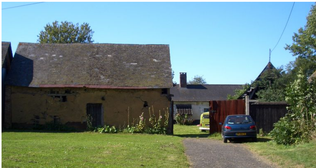
Vue générale depuis la place.
