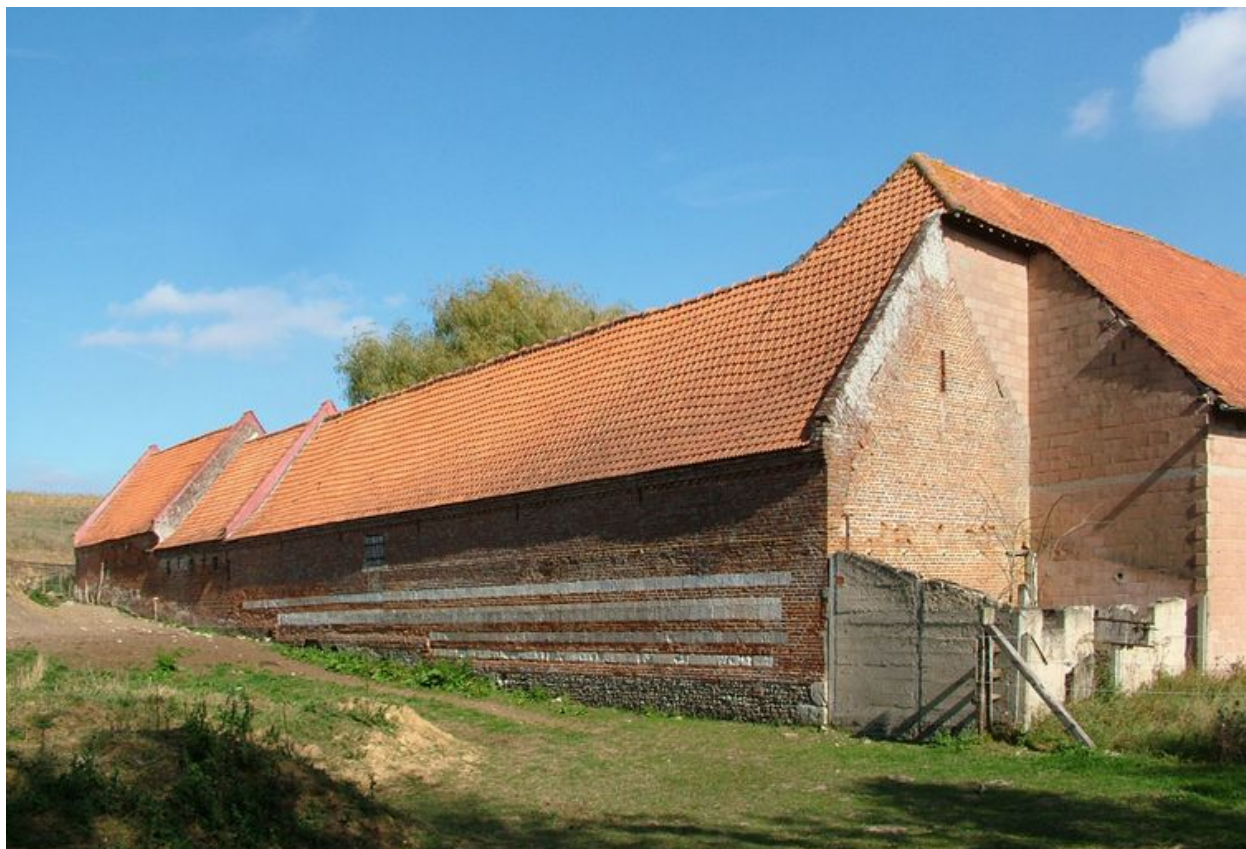
Vue extérieure des bâtiments d'exploitation à l'ouest.
