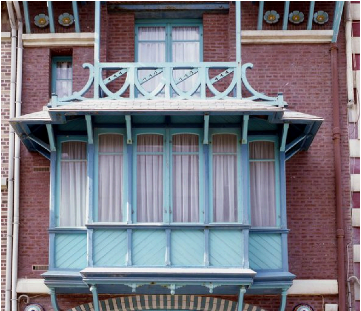
Détail du bow-window en surplomb.
