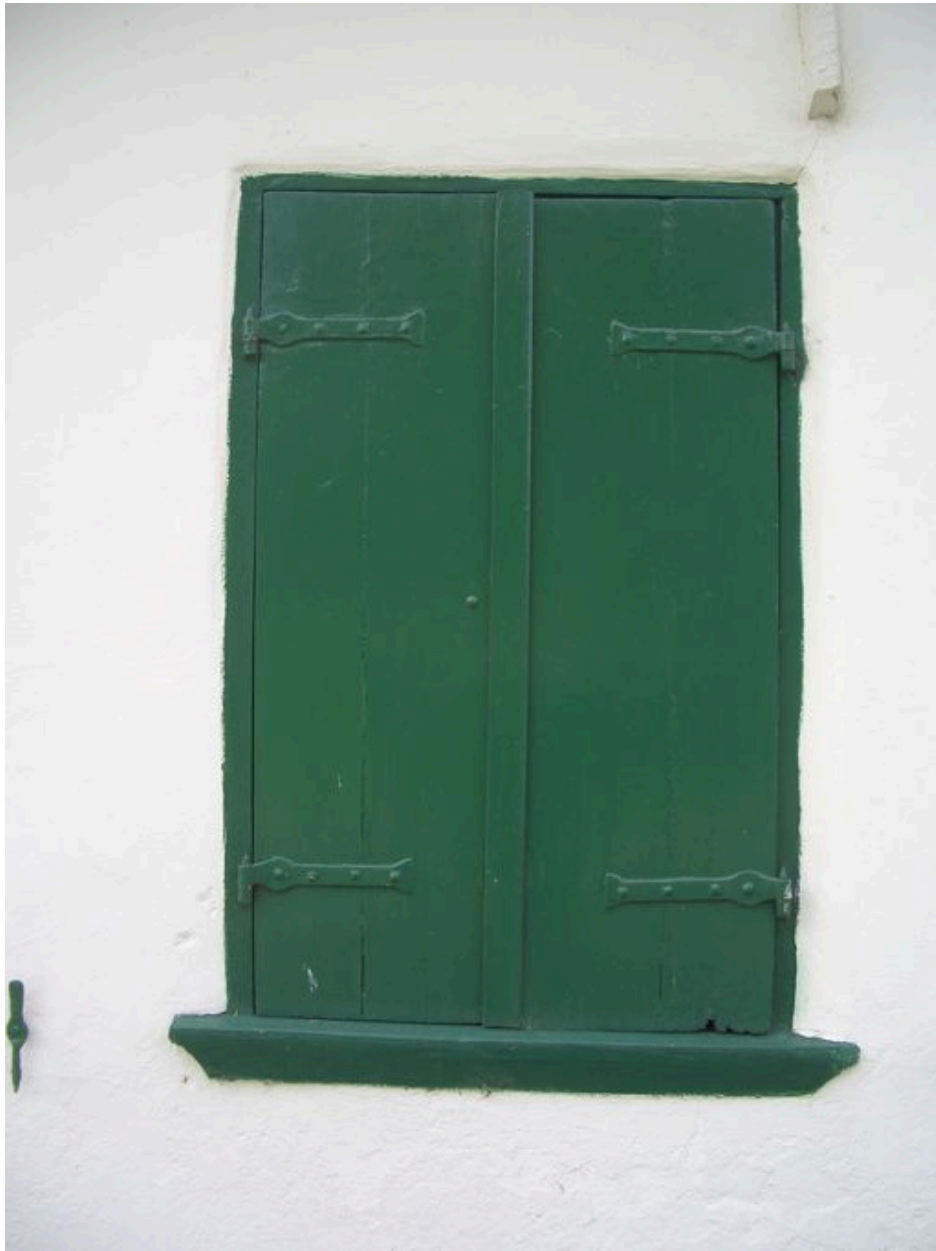
Détail du contrevent sur rue.
