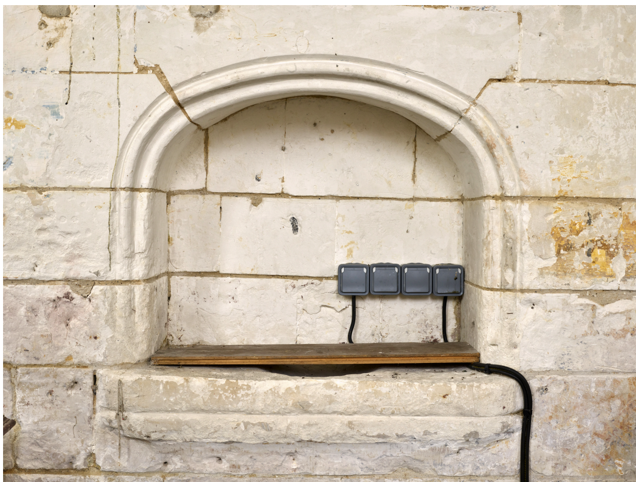
Intérieur, niche aménagée au sud du chœur.
