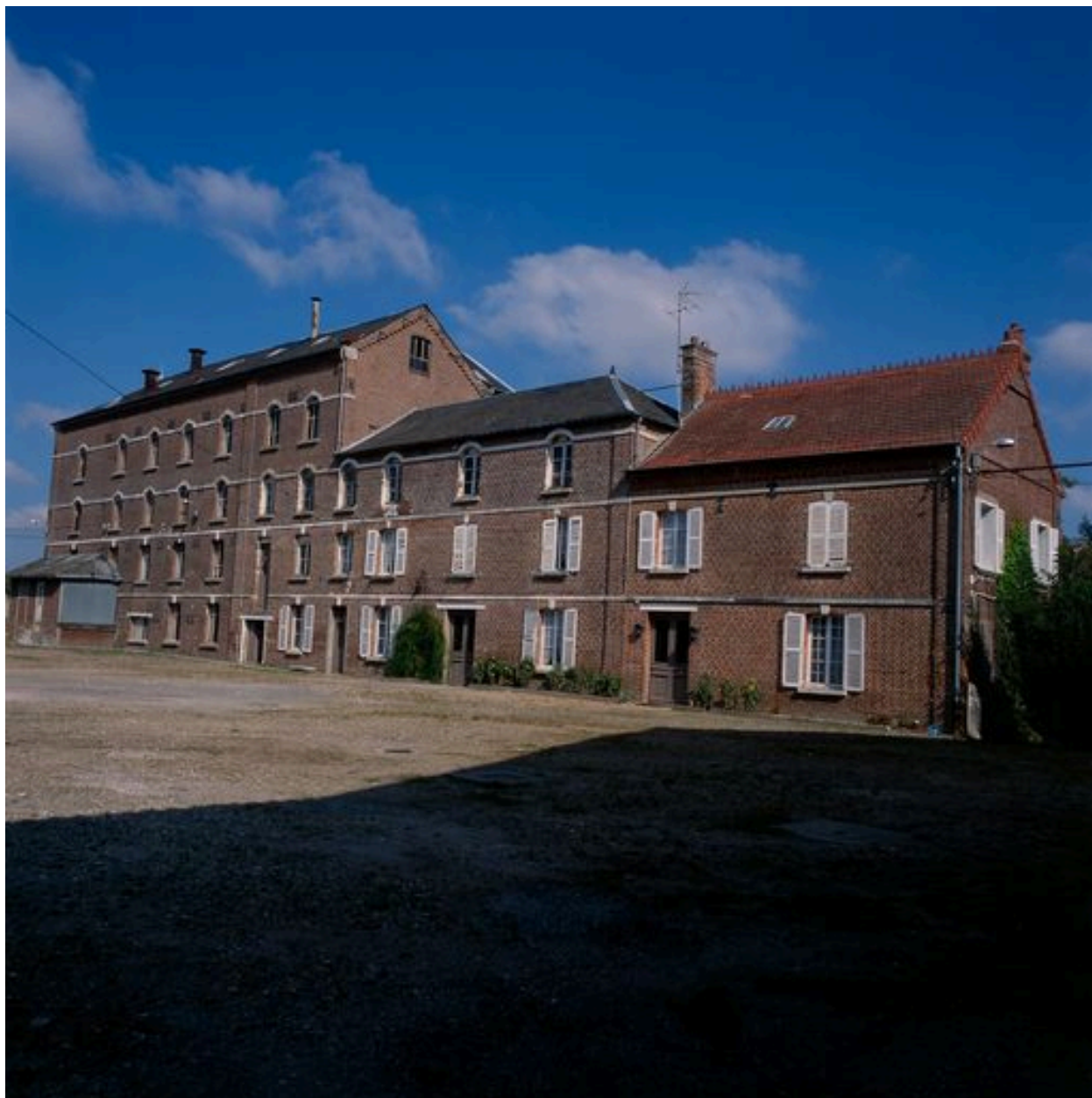
La minoterie et le logement d'habitation.
